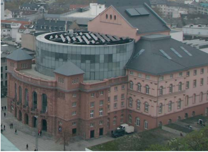
Kaum einer weiß es: Auch auf dem Staatstheater betreiben die Mainzer Stadtwerke eine Solaranlage. Foto: © Stephan Vormerker
